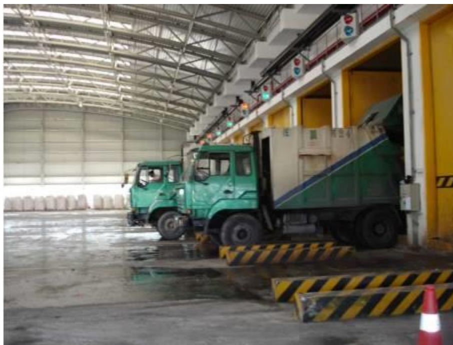
图 3.4-2 垃圾卸料大厅
