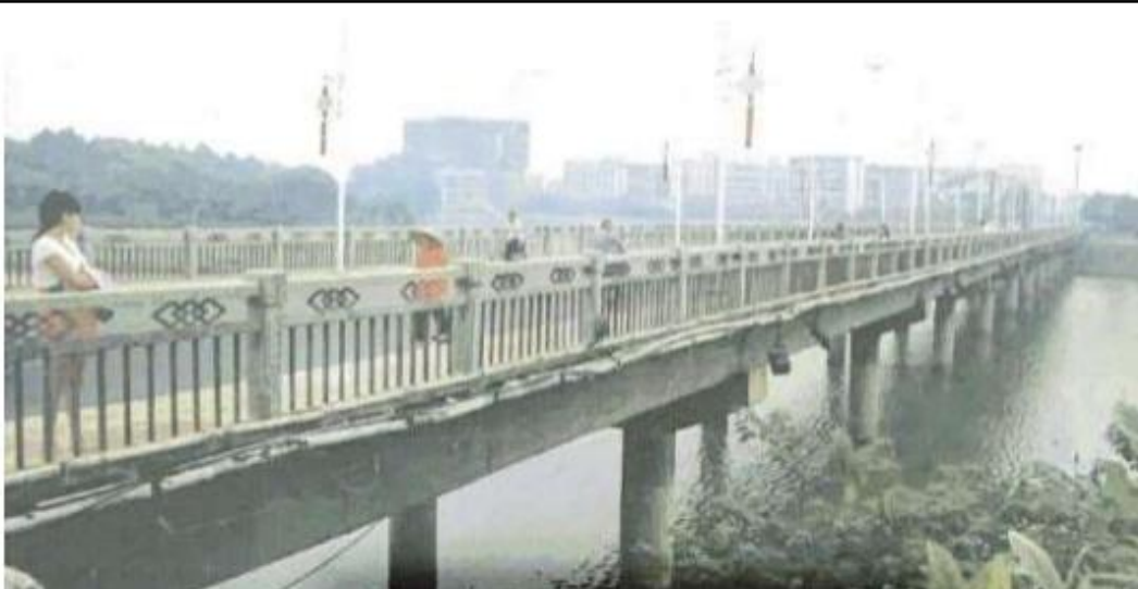
图 2.2-1 项目现状照片
