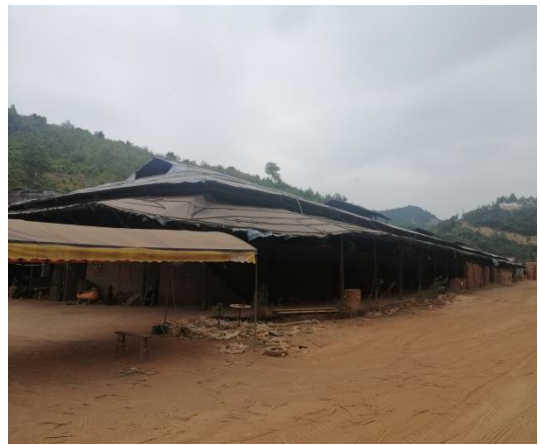
项目厂区现状
