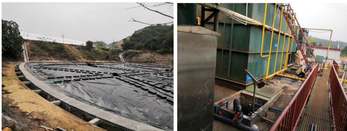
渗滤液收集池
